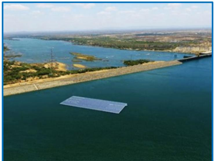
Photo 3: Le plan d'eau créé par le barrage de la centrale hydroélectrique de Sobradinho / Bahia, qui dispose désormais d'un système photovoltaïque (solaire) flottant de 1 MWc. Deux sources d'énergie pour répondre aux besoins en électricité de la région.
